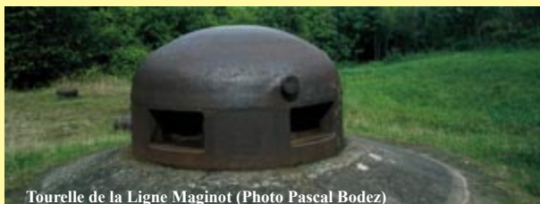
Tourelle de la Ligne Maginot (Photo Pascal Bodez)
