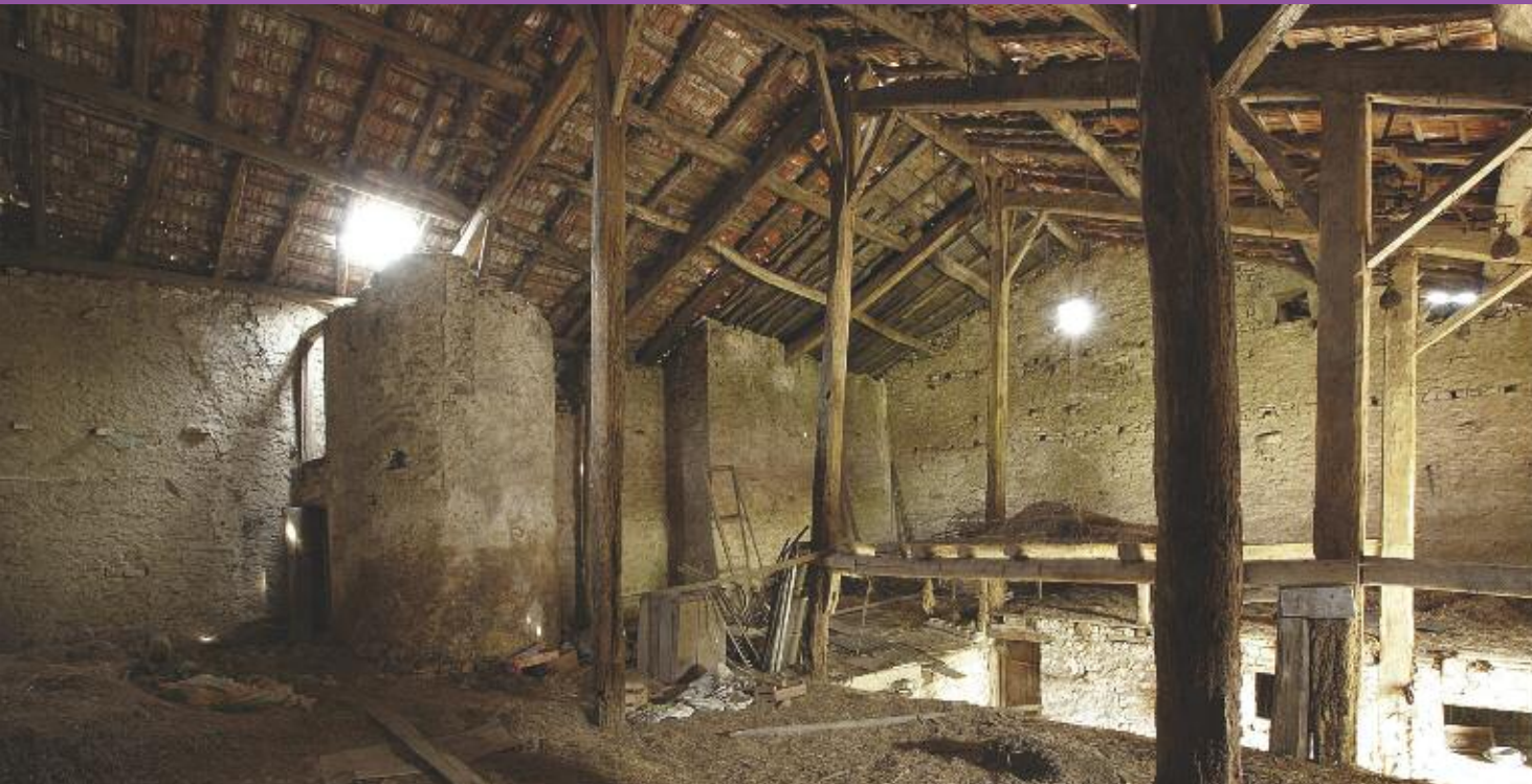
Ferme, 5 rue du Pressoir, 88 Ubexy. Vue des greniers et de la tour d'escalier. Photo L. Gury © Région Lorraine-Inventaire général
