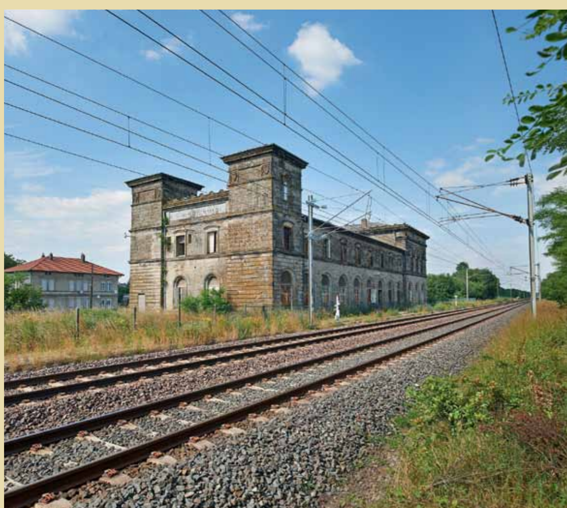
La gare depuis la voie ferrée.
