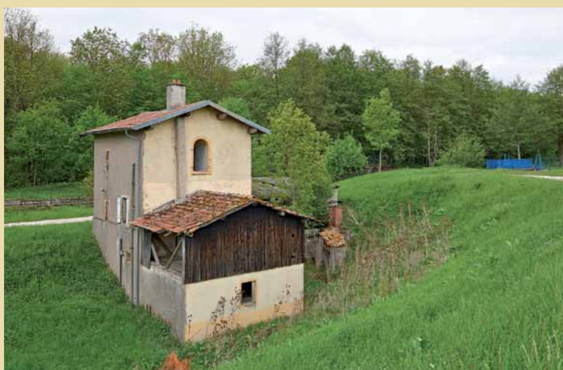
Maison éclusière de l'écluse n°2 à Réchicourt.
